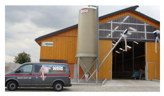
MEX Polyester Außensilos sind die ideale Lösung um Futter sicher zu lagern. Durch die Ausführung als Massenflusssilo wird die seitliche Ablagerung im Trichterkegel verhindert, bei Neubefüllung bleiben somit keine Futterreste im Kegel. Die glatten Innenwände verhindern das Anhaften des Futters.
